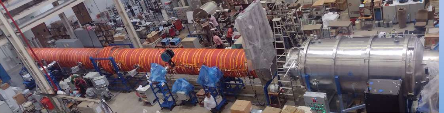
प्लाज़्मा अनुसंधान संस्थान में लीगो-भारत विस्टा सुविधा के लिए क्रायो-पंप के संस्थापन का चित्र
